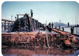
干拓堤防工事の様子(昭和34年)
